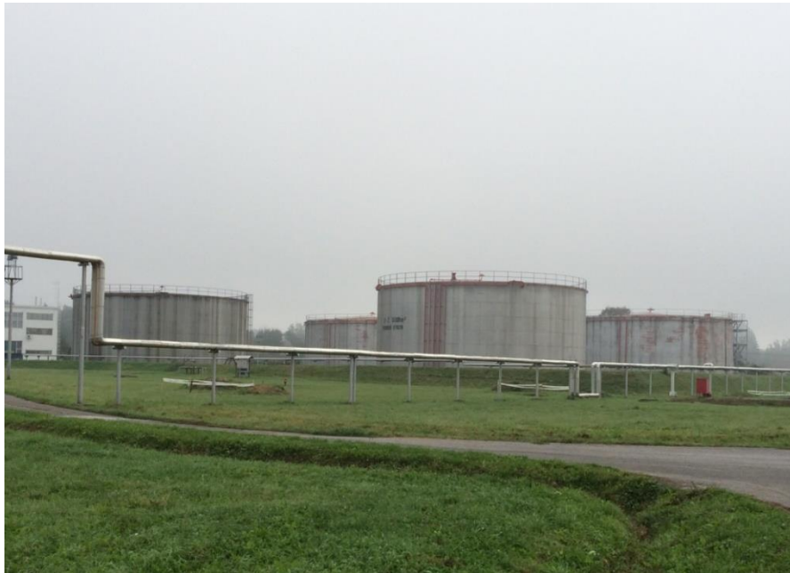
Slika 28. Spremnici mješavine nafte i plinskog kondenzata (svaki po 5 000 m 3 )
